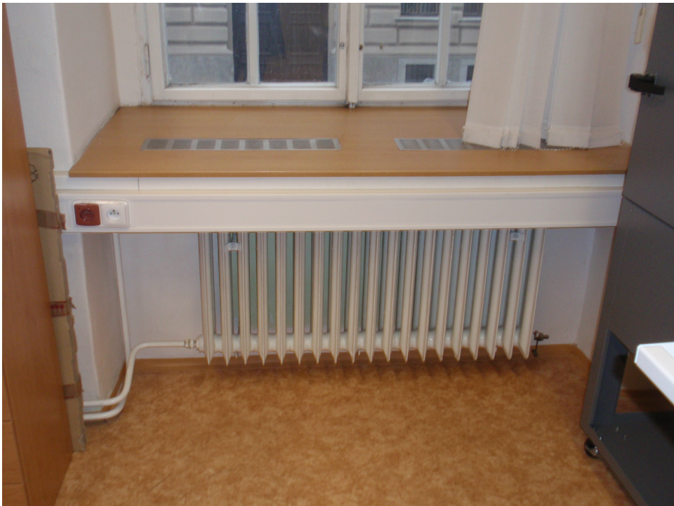
Příklad analogického řešení vedení parapetních kabelových žlabů v 1.NP v prostorách NTC
