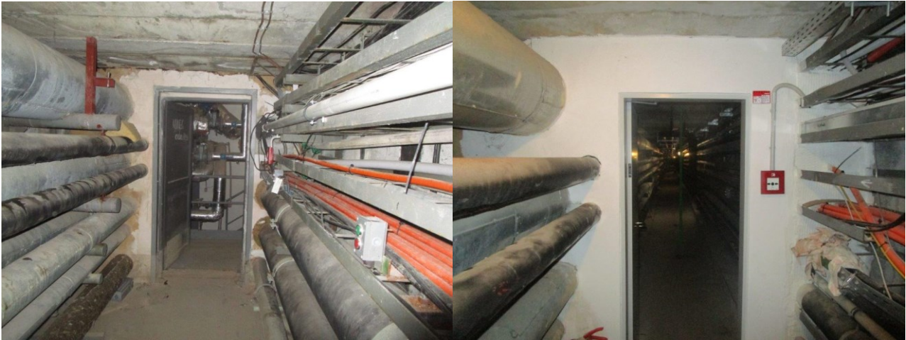
Fotografie 4, 5: Situace – Kolektory pod kampusem
