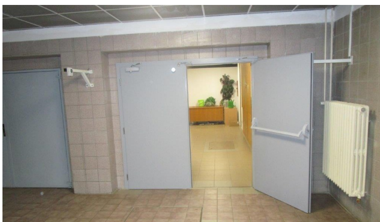
Fotografie 42: Požární dveře na Fakultě strojní, drženy magnety v otevřené poloze, uzavření na základě signálu ze systému EPS
