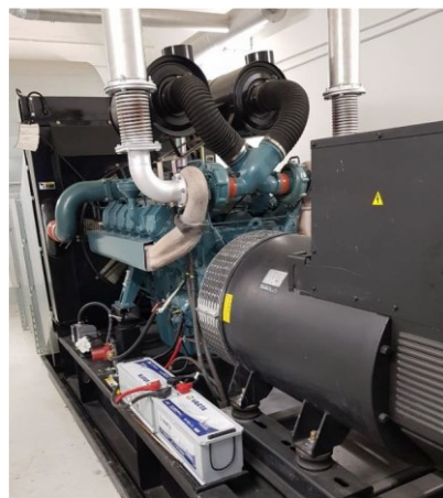
Fotografie 41: Náhradní diesel agregát v centrálním výměníku
