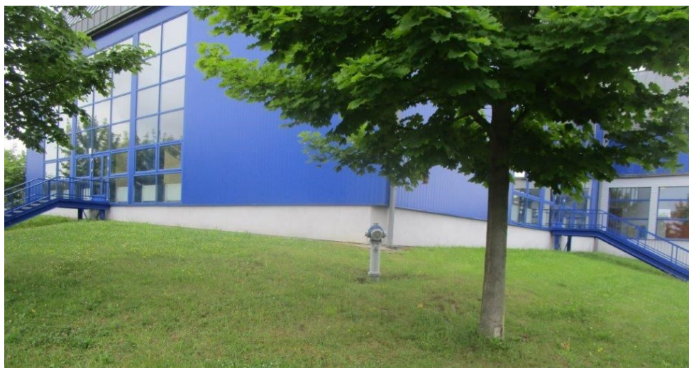
Fotografie 32: Nadzemní hydrant v areálu kampusu
