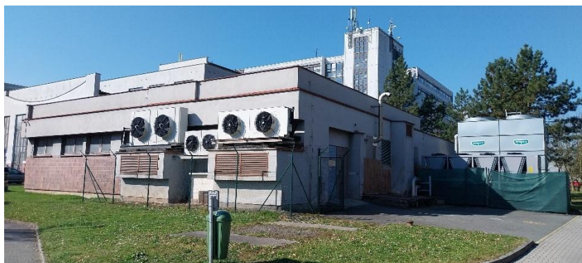
foto č. 17 a 18 – objekt centrální výměňkové stanice (je zde vstup do podzemních kolektorů)
