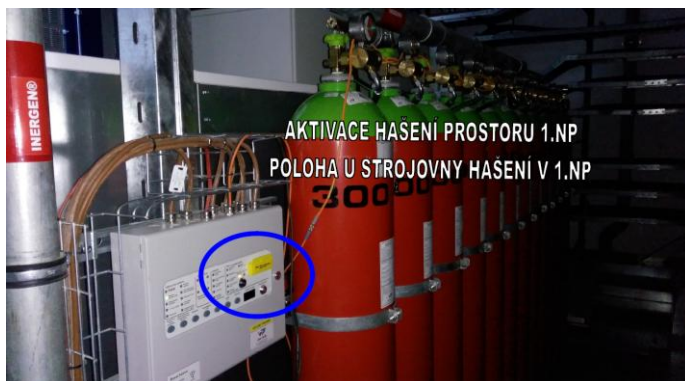
foto č. 5 – aktivace stabilního hašení pro prostor zkušebny motorů
