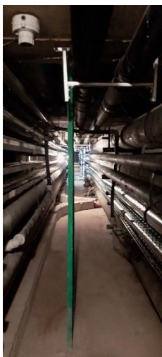
foto č. 1 – prostor kolektorů
