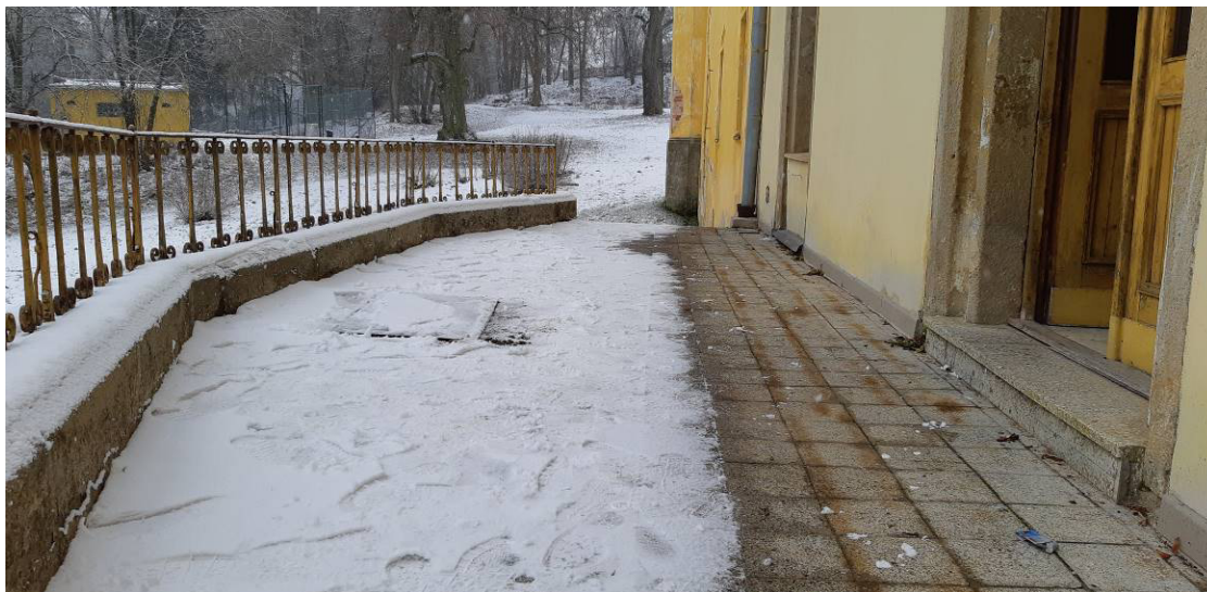
Detail pravého parapetu schodiště (popraskaná omítka a uvolněné kamenný parapet)
