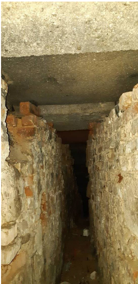
Dodatečné podepření stropu cihelnou zdí (vpravo)
