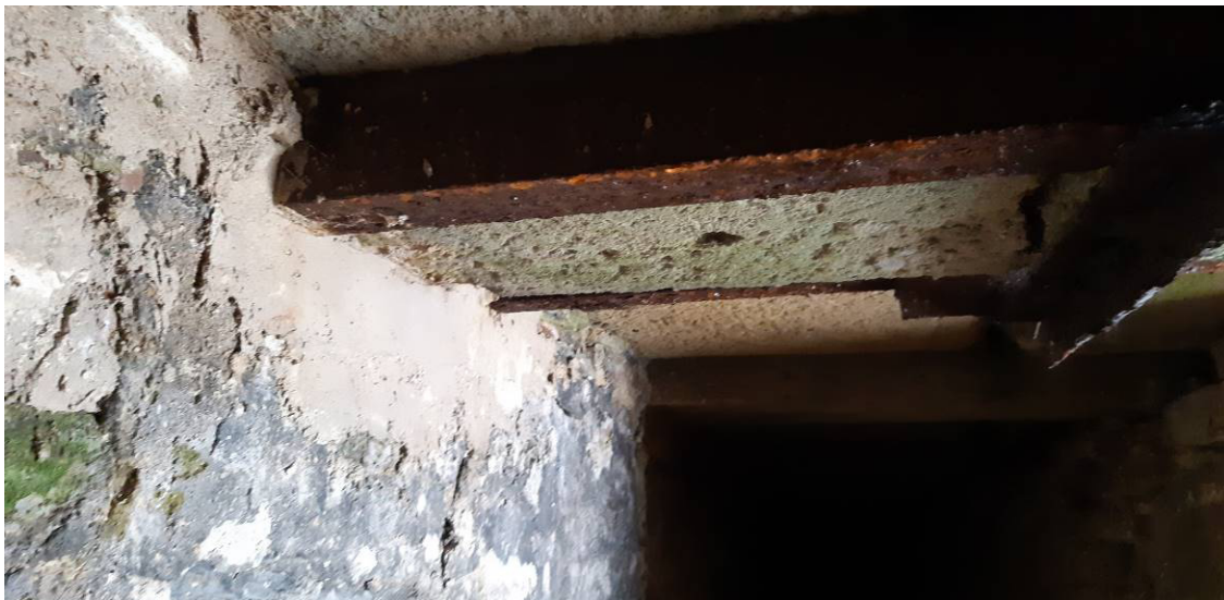
Ocelový překlad nad vstupem do suterénu pod zámkem
