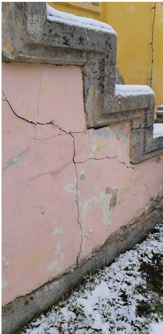
Detail pravého parapetu schodiště (popraskaná omítka a uvolněné kamenný parapet)
