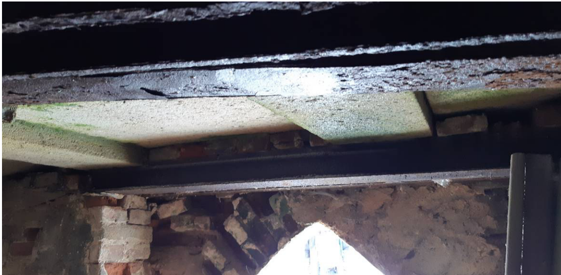
Pohled na konstrukci stropu pod terasou (východní část)- prasklý kamenný průvlak
