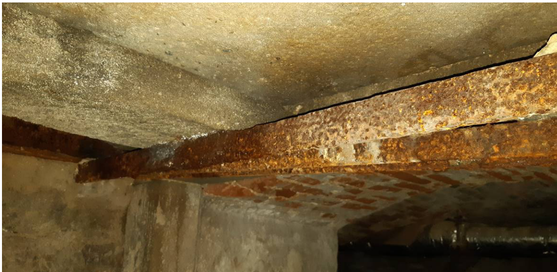
Ocelový překlad nad vstupem do suterénu pod zámkem
