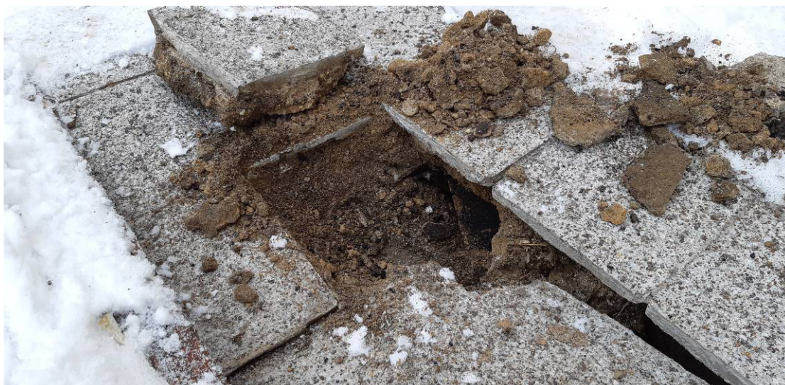
Sonda skladby terasy v místě propadnutí (dlažba teraco, pískový podsyp, beton, kamenné desky)
