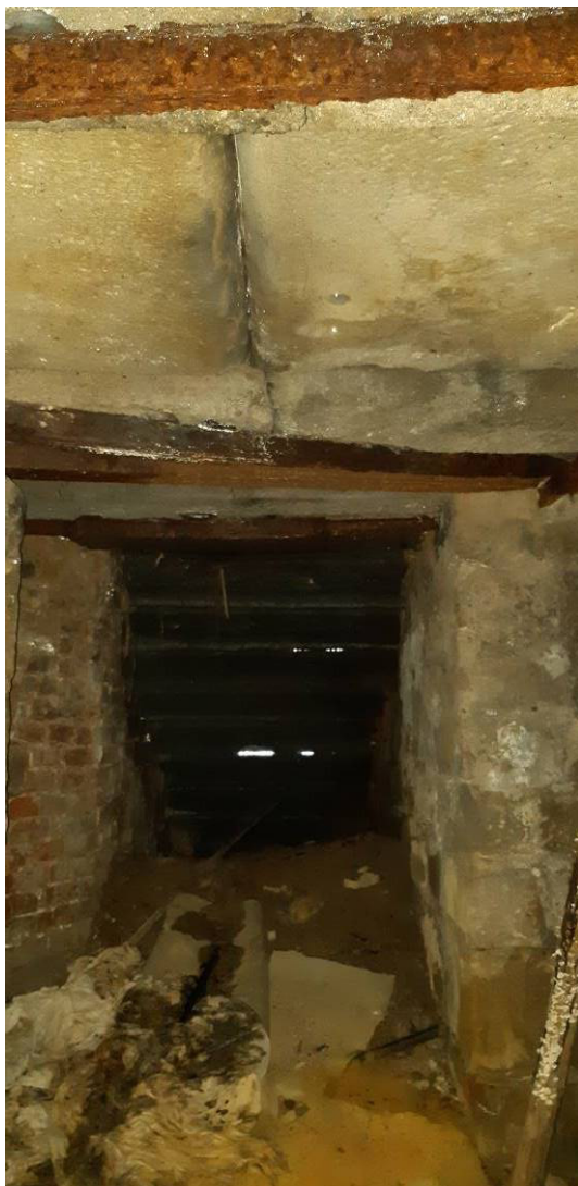
Konstrukce stropu pod terasou
