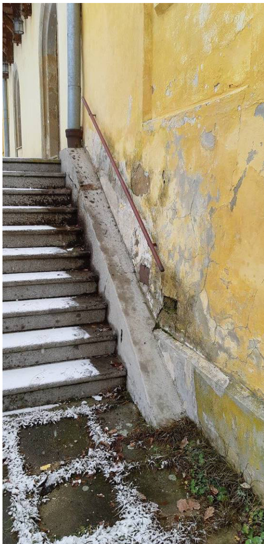
Zabetonovaný dešťový svod, který bude odstraněn
