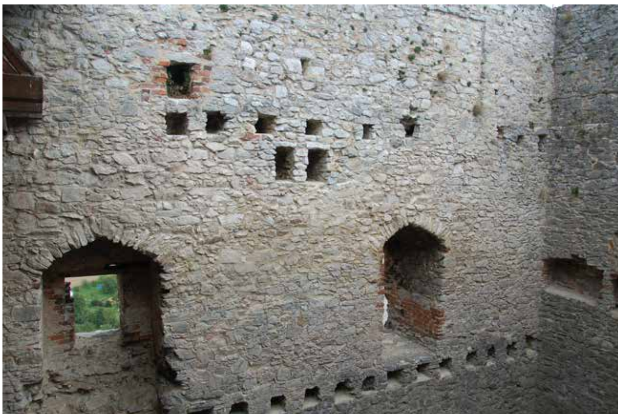
Obr. 28. Hrad Rabí (okr. Klatovy). Otvory po stropních trámech v úrovni pátého podlaží nad okny s mírně hrotitým záklenkem a sediliemi v úrovni čtvrtého podlaží. Foto autor 2017. – Abb. 28. Rabí (Bez. Klattau). Deckenbalkenlöcher im fünften Stockwerk über den Fenstern mit einem wenig gebrochenen Karnies und Sedilien im vierten Stockwerk. Foto Autor 2017.
