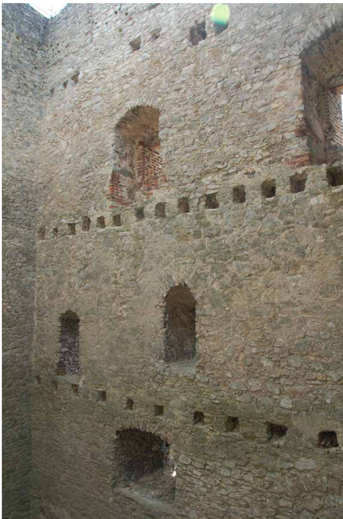
Obr. 27. Hrad Rabí (okr. Klatovy). Pohled na severovýchodní stěnu interiéru donjonu s otvory po instalaci stropních trámů v jednotlivých podlažích. Foto autor 2017. – Abb. 27. Rabí (Bez. Klattau). Der Blick auf die nordöstliche Mauer des Donjon-Innenraums mit den Deckenbalkenlöchern in den einzelnen Stockwerken. Foto Autor 2017.
