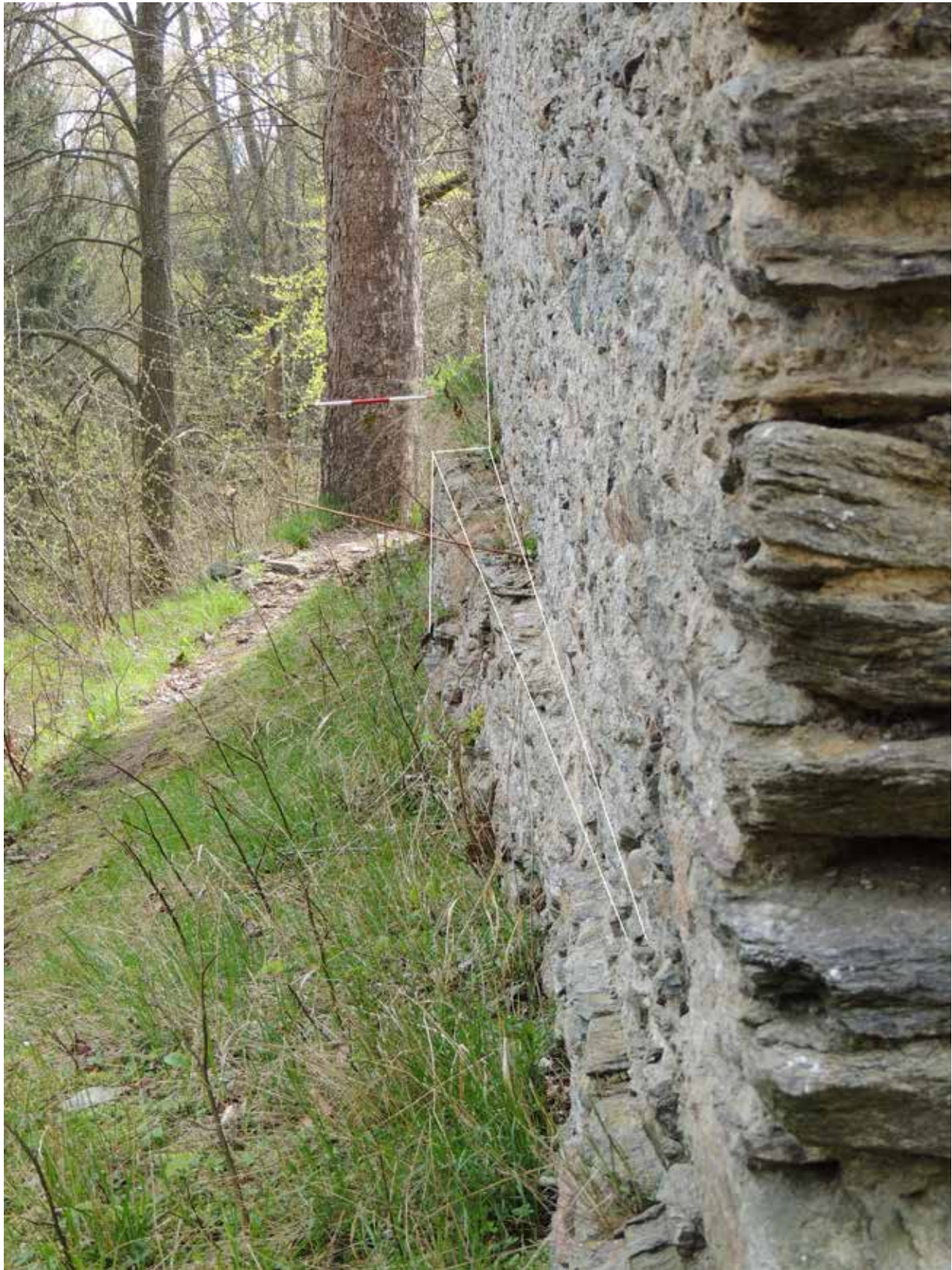
Obr. 15. Pajrek (okr. Klatovy). Odsazení základového zdiva na severní straně donjonu. Foto a úprava autor 2016. – Abb. 15. Beyereck (Bez. Klattau). Der Absatz des Grundmauerwerks auf der Nordseite des Donjons. Foto und Bearbeitung Autor 2016.
