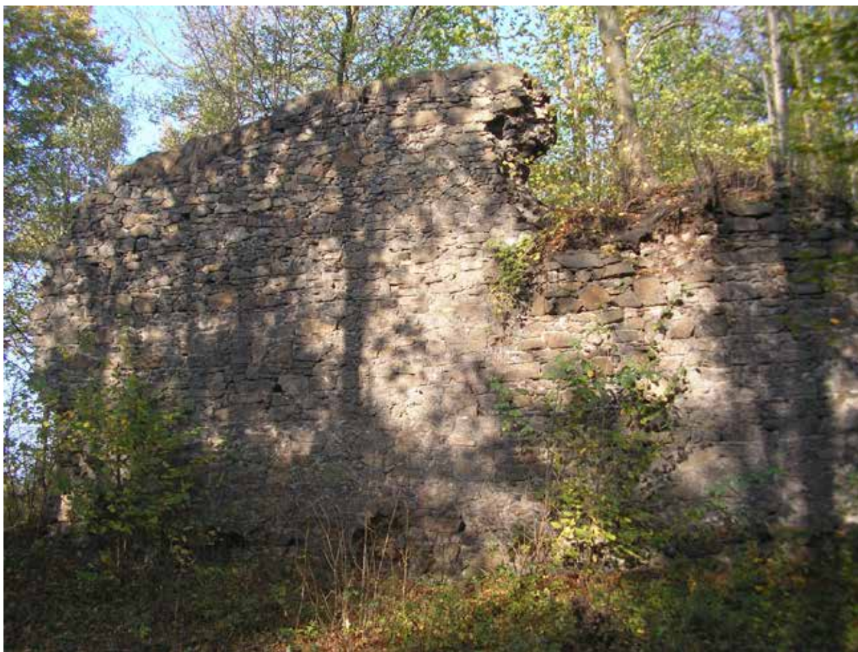
Obr. 7. Zdivo jádra hradu Ronov od jihozápadu. Foto Templariusbohemicus 2016 ( https://commons.wikimedia.org ). – Abb 7. Die Burg Rohnau – das Mauerwerk des Burgkernes. Foto Templariusbohemicus 2016 ( https://commons.wikimedia.org ).
