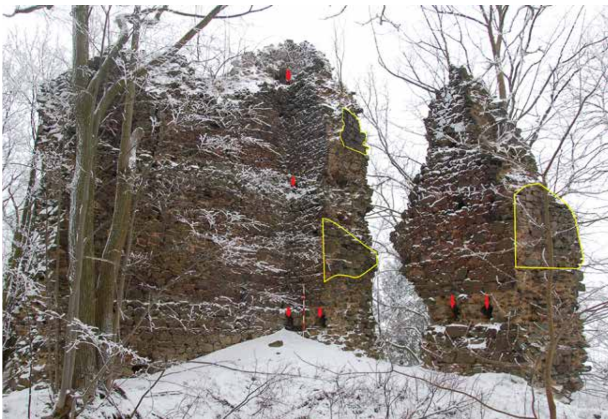
Obr. 12. Netřeb (okr. Domažlice) – Západní obvodová zeď s otvory (označeno šipkou) po osazení stropních trámů v jednotlivých podlažích. Foto a úprava autor 2017. – Abb. 12. Neu Riesenberg (Bez. Taus). Die westliche Ringmauer mit den Deckenbalkenlöchern in den einzelnen Stockwerken. Die Fensterlaibungen gelb markiert. Foto und Bearbeitung Autor 2017.
