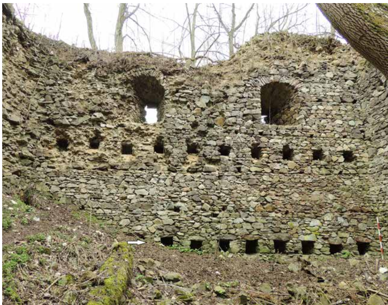
Obr. 22. Nový Herštejn (okr. Domažlice). Pohled na východní obvodovou zeď v interiéru donjonu s otvory po stropních trámech. Foto Zlata Gersdorfová 2016. – Abb. 22. Neu Hirschstein / Neu Herrnstein (Bez. Taus). Der Blick auf die östliche Mauer im Innenraum des Donjons mit den Deckenbalkenlöchern. Foto Zlata Gersdorfová 2016.
