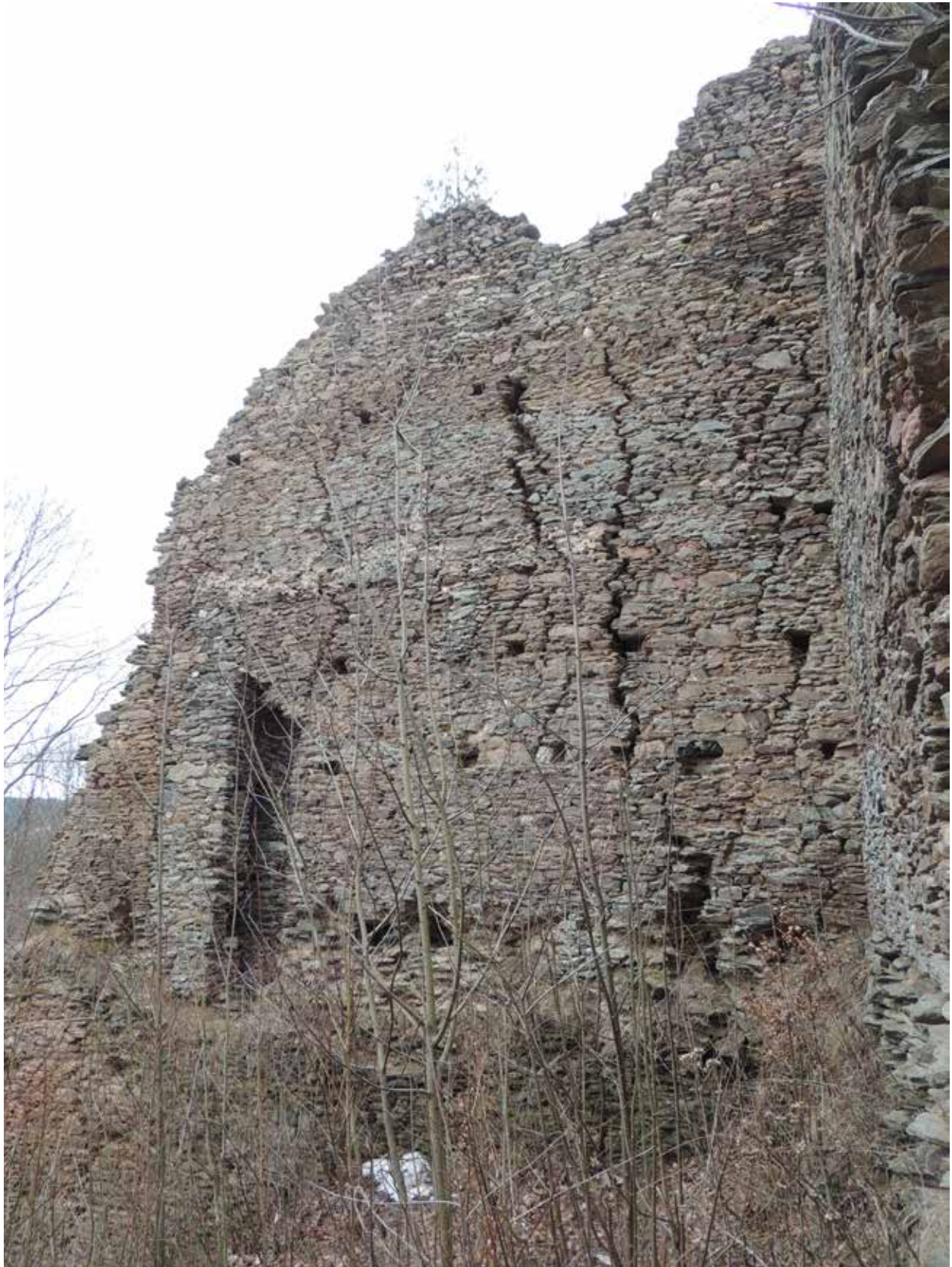
Obr. 17. Pajrek (okr. Klatovy). Pohled na západní obvodovou zeď v interiéru donjonu. Foto Zlata Gersdorfová 2016. – Abb. 17. Beyereck (Bez. Klattau). Der Blick auf die westliche Mauer durch den Innenraum des Donjons. Foto Zlata Gersdorfová 2016.
