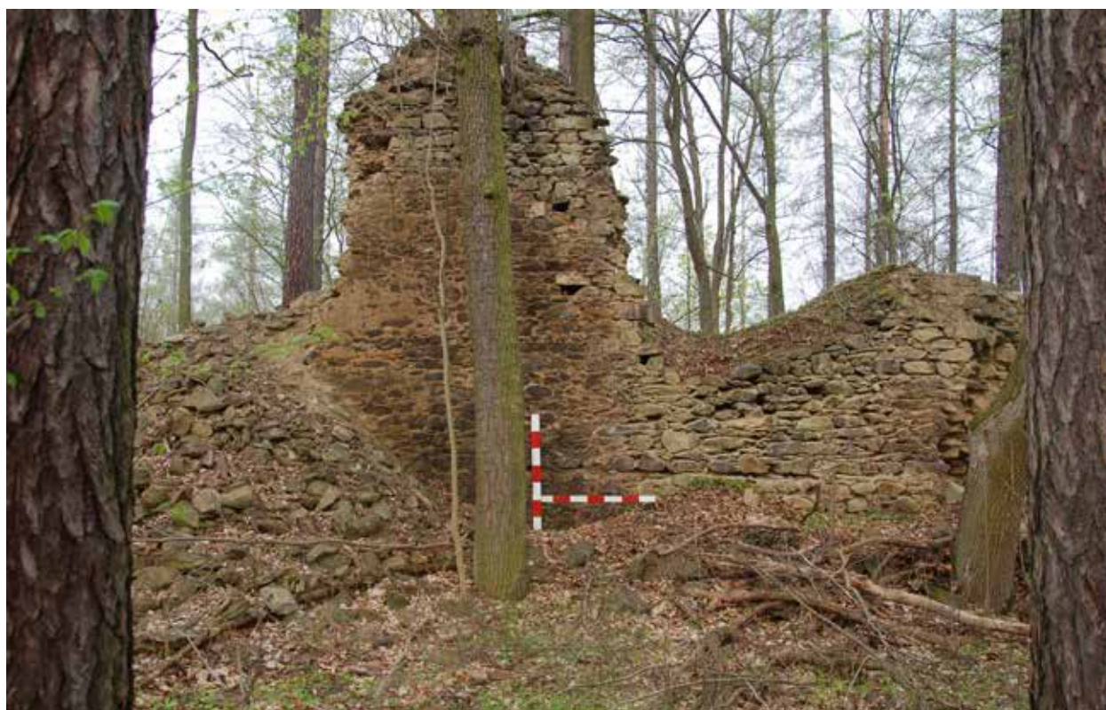
Obr. 4. Pušperk (okr. Klatovy). Vnější líc východní zdi donjonu. Foto autor 2014. – Abb. 4. Puschberg / Fuchsberg (Bez. Klattau). Die östliche Außenmauer des Donjons. Foto Autor 2014.
