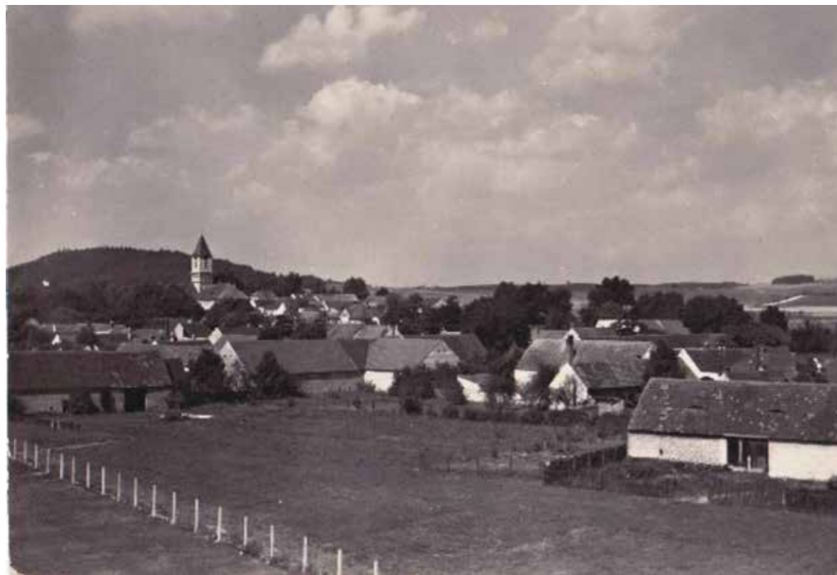
Obr. 3. Katovice. Rok 1964. Foto od jihovýchodu. Zdroj:
