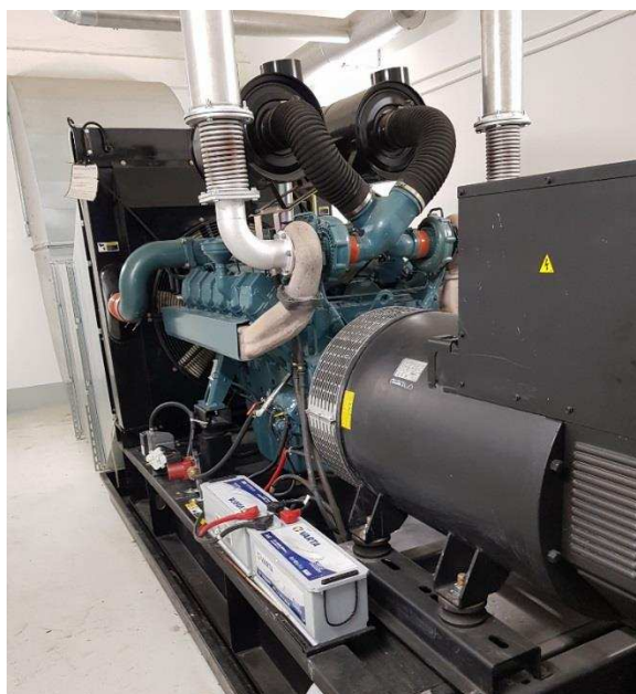
Obrázek 1: Diesel agregát v objektu centrálního výměníku
